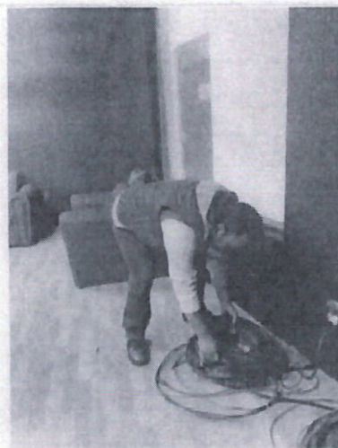
Se realizó revisión de conexiones en cableado
