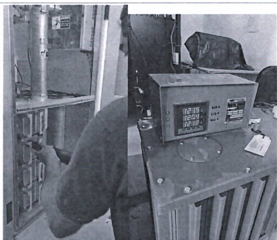
Mantenimiento al transmisor de FM y regulador de voltaje, chequeo de salidas de voltaje
